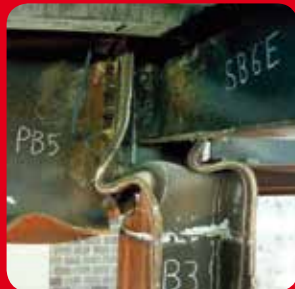
Trave portante in acciaio collassata dopo un incendio
