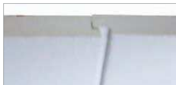
BATTENTE PER INCASTRO RIMANENTE FUGA DA cm 1x1 A VISTA
