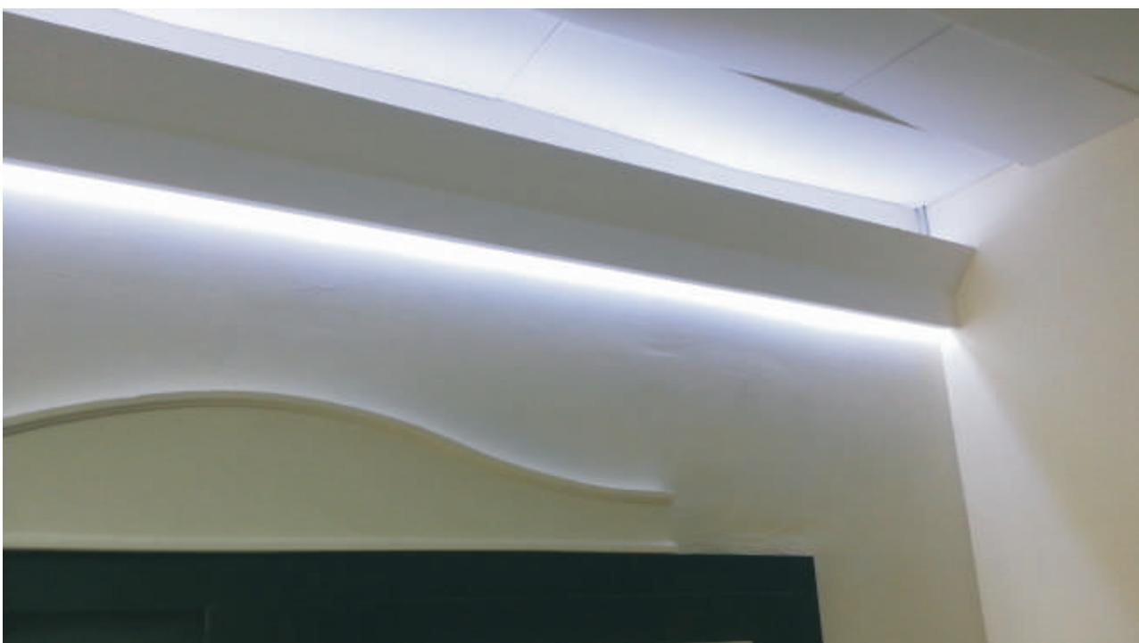
*Particolare di parete con cornice LED 7 con striscia led posta sopra e sotto per ottenere una luce bidirezionale*
