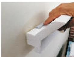
11- Inserire il Profilo Dissipatore per alloggiare la striscia Led
